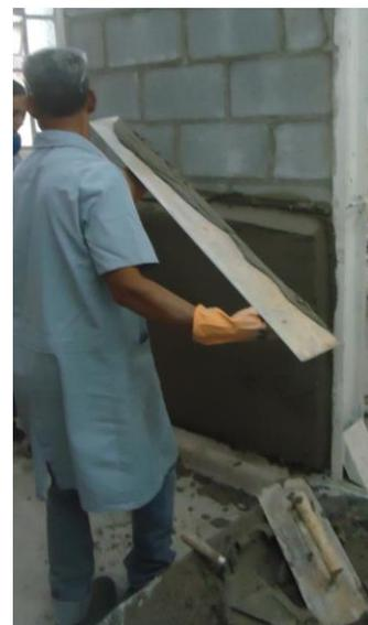
**Foto 7** – Etapa de acabamento da superfície do revestimento
