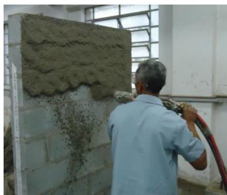
**Foto 2** – Aplicação da argamassa por projeção mecânica.
