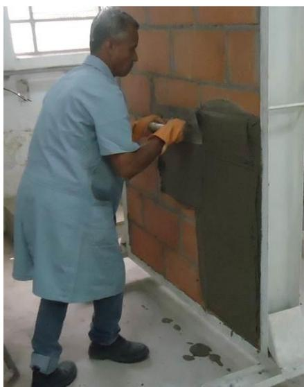
**Foto 5** – Aplicação da argamassa de forma manual
